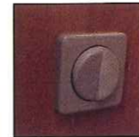
Innen-/Außenlichtschalter im Eingang
