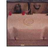
Einbau Frischwassertank 45 l
