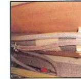
Frostgeschützte Wasserleitungen über Warmluftschlauch verlegt
